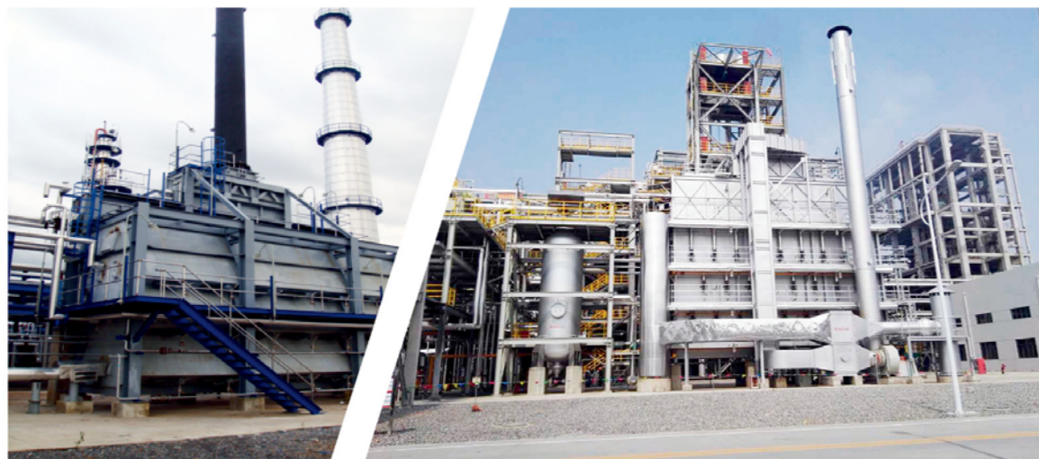
CS 2 反应炉 CS 2 Reaction furnace
